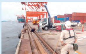
スケールの大きい海上土木現場。
