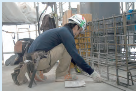
型枠の精度が、そのまま建物の完成度につながります。
