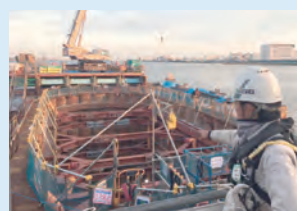
現在担当している 羽田連絡道路の 現場。
